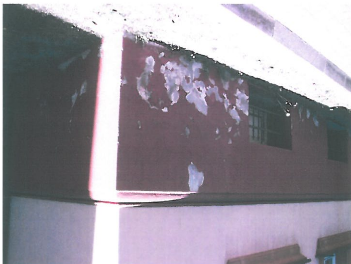
il.11 fragment zniszczonego tynku cokołu elewacji frontowej
