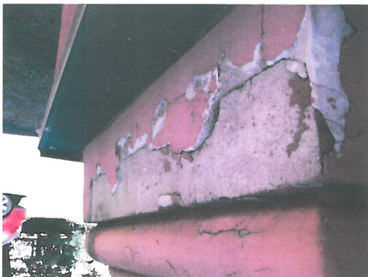
il.12 fragment uszkodzonej bazy pilastra w elewacji tylnej
