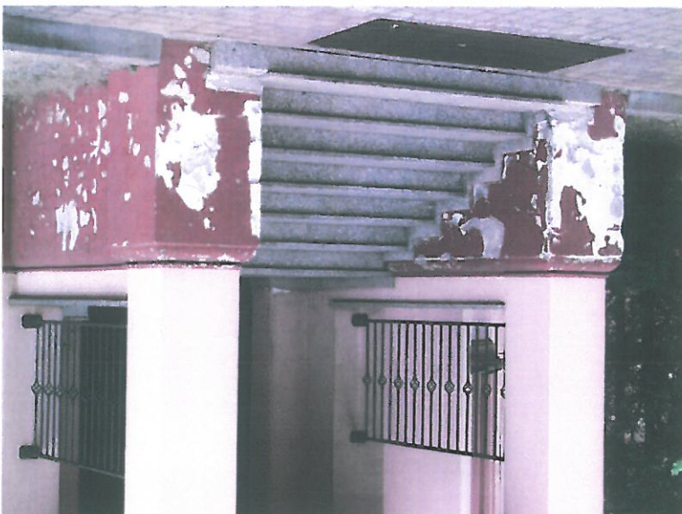
il. 8 ubytki i odparzenie tynku na przy wejściu do budynku
