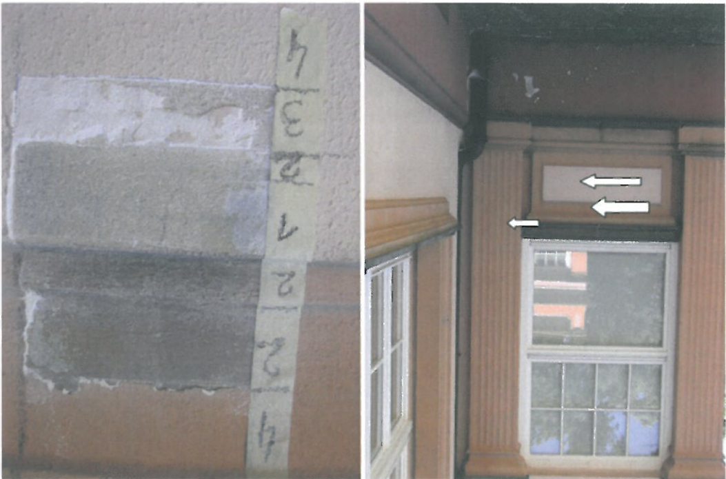
il.22 odkrywka E3 gzyms i płycina podokienna
