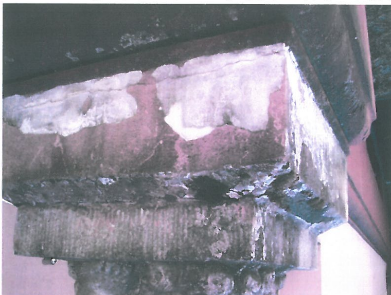
il. 10 elewacja tylna, ubytki tynku na postumentach rzeźb
